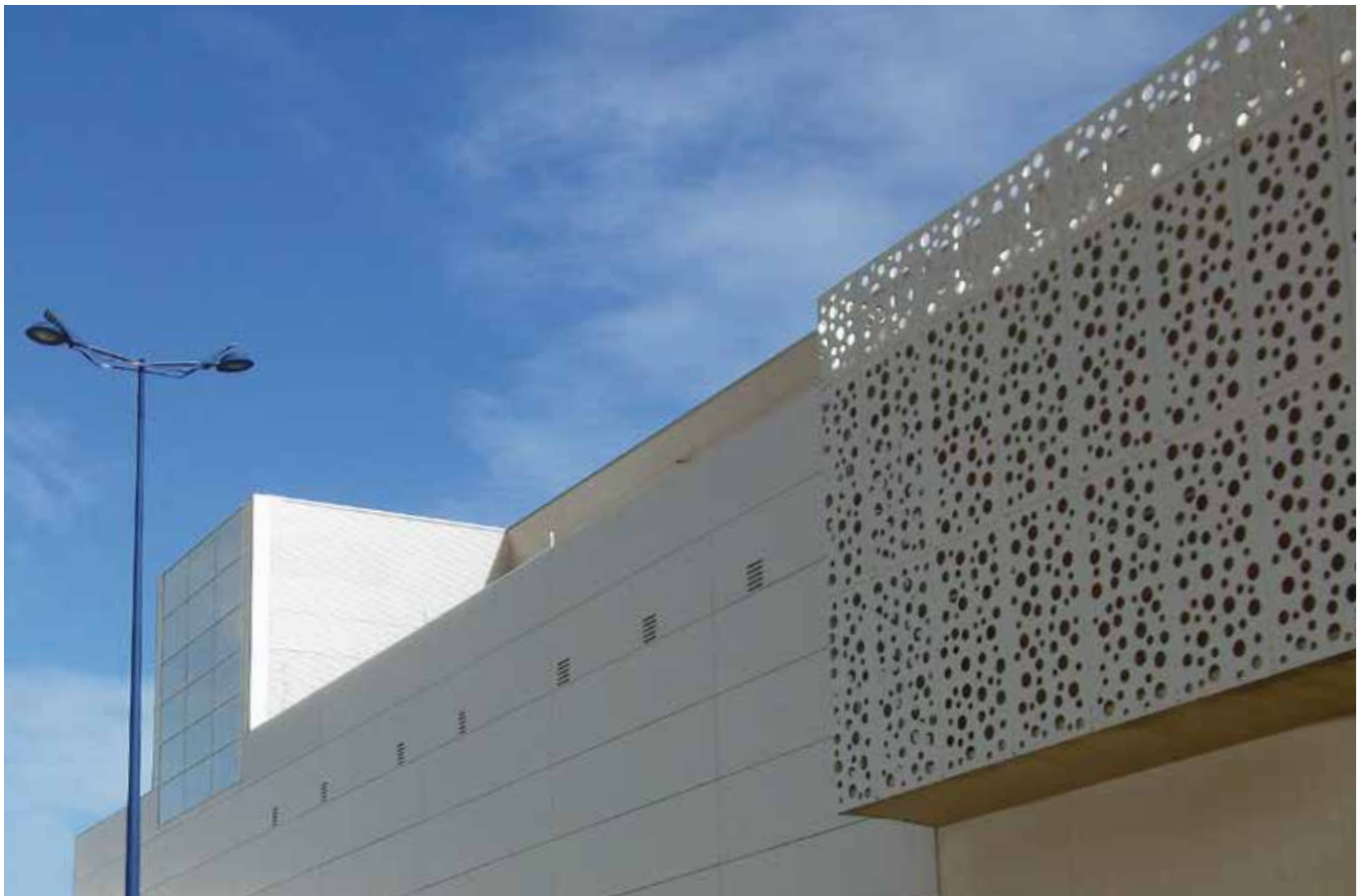
Centre Commercial Abella. Lugo (Espagne) ARCHITECTE: Manuel Villar
