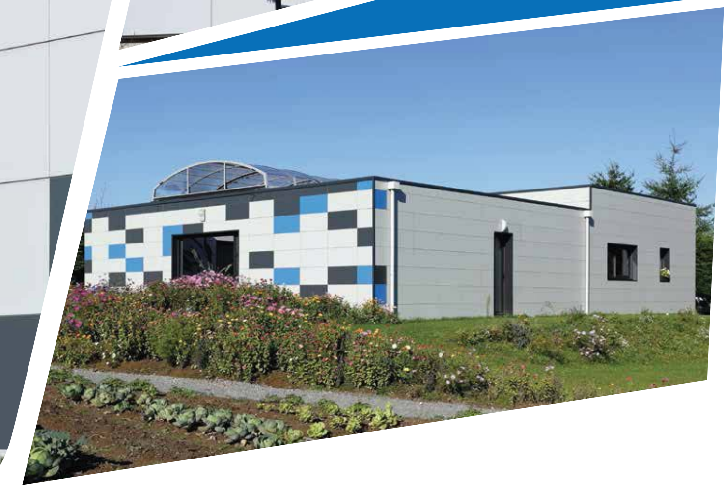
MAISON PRIVÉE Maison individuelle Le Ham, France
