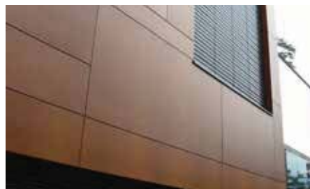
Caserne de pompier, Saltaus, Italie Design monolithique, entouré de nature. Conçu par les architectes Menz + Gritsch.
