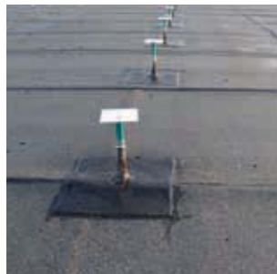
Ripristino della guaina tramite fissaggio a caldo di nuova membrana bituminosa Sheath re-establishment by heat fixing of a new bituminous sheath
